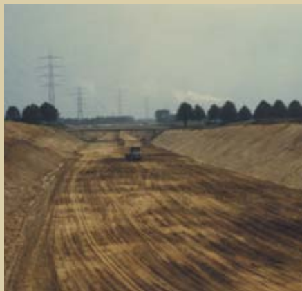
Bau der A31
